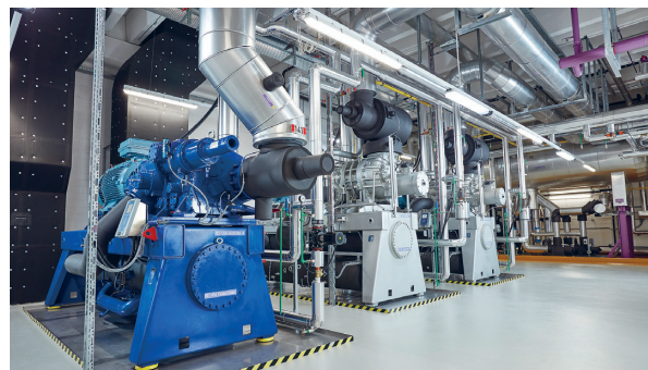
Abbildung 4: Ammoniak-Kälteanlage für die Industrie
