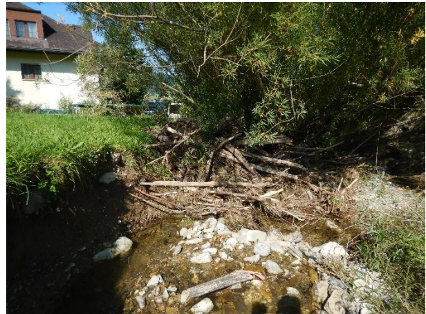
Abbildung 8: Schwemmholzverklausung vor dem Durchlass Zufahrt Schnetzlers vom 12.8.2021
