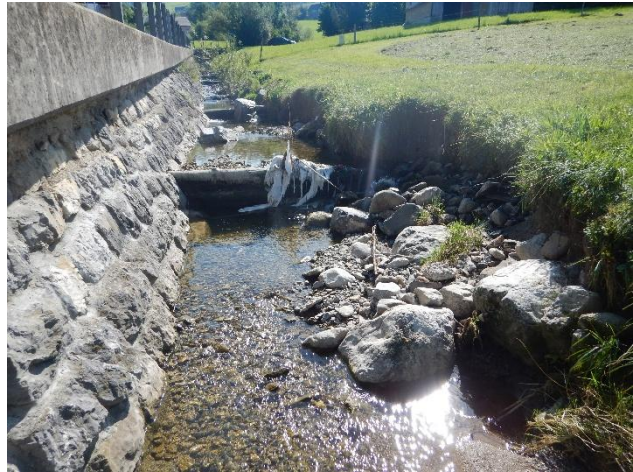
Abbildung 15: nicht fischgängige Holzschwelle in schlechtem Zustand
