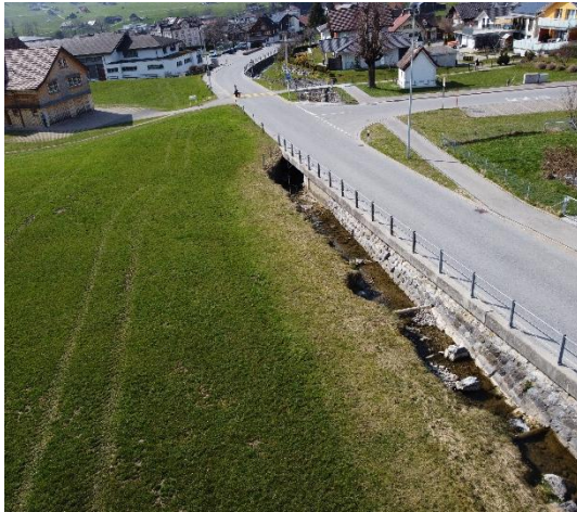
Abbildung 14: Durchgehender rechtsufriger Längsverbau vor dem DL Pöppelstrasse
